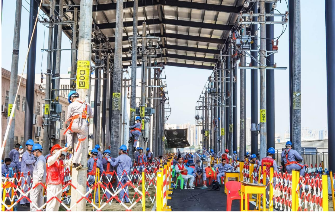
图 2-2 长沙电力职院配电运维校内实训基地
